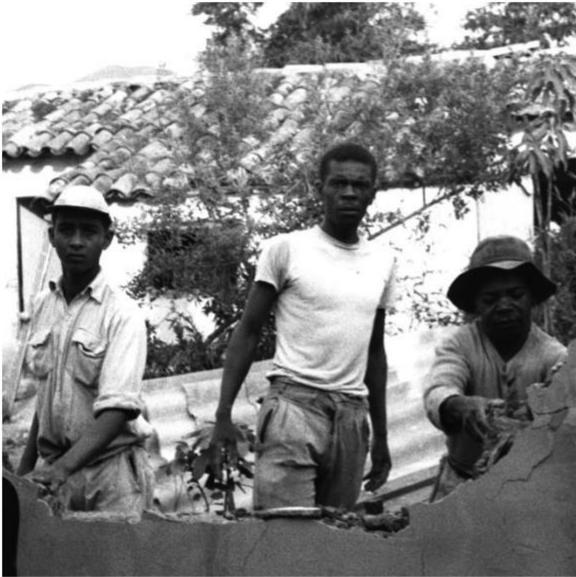
Demolição de barracão clandestino usados para fins comerciais. Sem data. Gestão não identificada.
