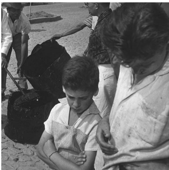
Prefeito visita obras no Padre Eustáquio, asfaltamento da Praça São Vicente de Paulo À esquerda: Prefeito Amintas de Barros (com suspensórios). Sem data, aproximadamente 1960. Gestão Amintas de Barros.
