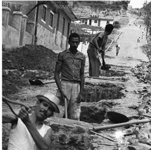
Nova rede de esgoto concluída na rua Tenente Anastácio Obras de saneamento na Rua Tenente Anastácio de Moura, no bairro Santa Efigênia. Julho de 1965. Gestão Oswaldo Pierucetti.
