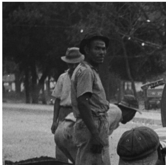
Obras na Avenida dos Andradas próximo ao Parque Municipal. Ao fundo e à direita, Viaduto Santa Tereza. Sem data. Gestão Américo Renê Giannetti
